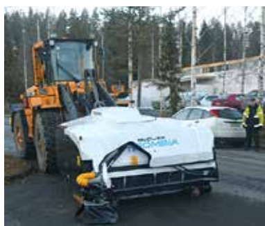
Feing og oppsamling av løv om høsten.
